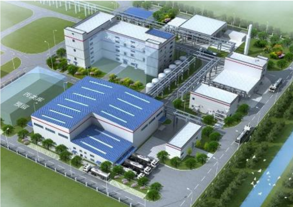
Die Investition transformiert die Anlage an der Daya-Bucht bis 2023 zu einem strategisch wichtigen Standort.
